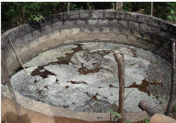
Figura 32. O tanque de deposição do vinhoto.
