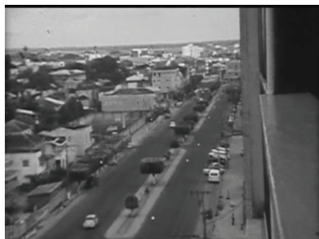
Avenida no centro de Manaus, em 1971. Um registro da cidade que revela o progresso numa visão modernizadora, em que o automóvel é protagonista.
